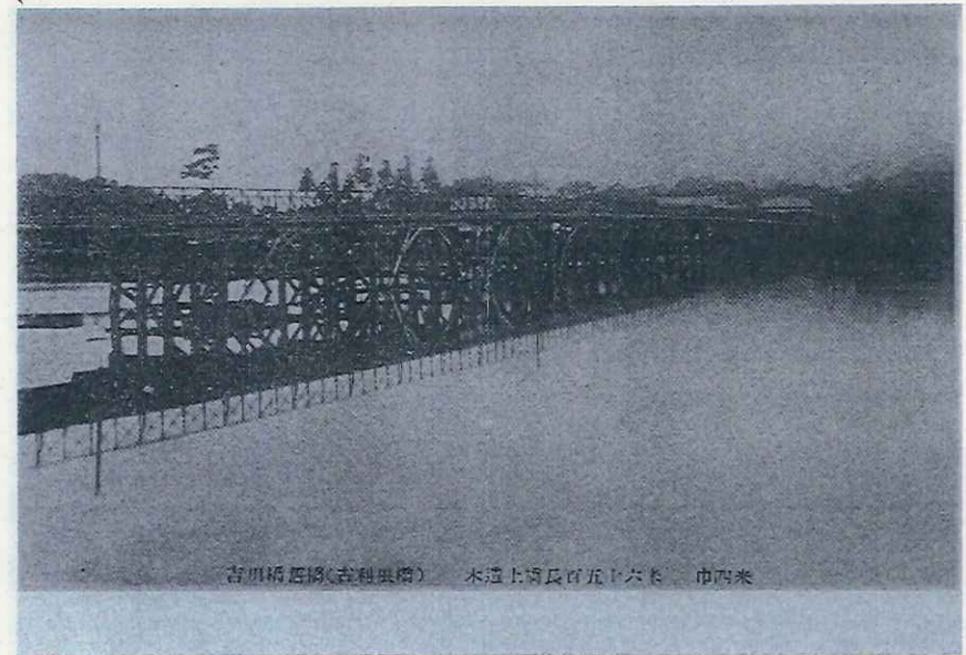
大正6年頃 二代目吉川橋(古利根橋)
